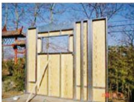
日本KC体系轻钢房屋安装实景图
