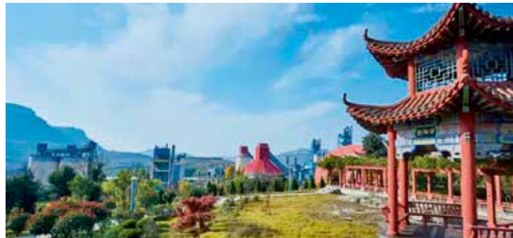
在爆破原址上建设的“花园式水泥工厂”
